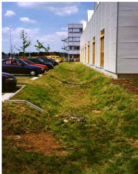
Abb. 4 - 9 Versickerungsmulde mit oberirdischen Zuläufen
