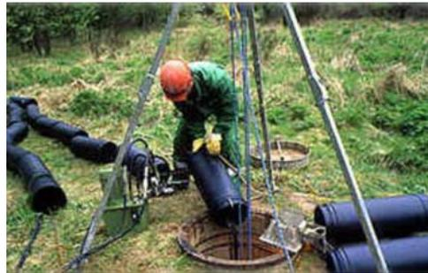
Abb. 4 - 10 Reparatur und Renovierung einer Haltung
