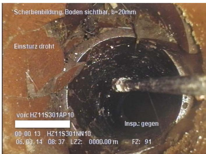
Abb. 4 - 8 Schadenssituation in einem Regenwasserkanal mit sofortigem Handlungsbedarf
